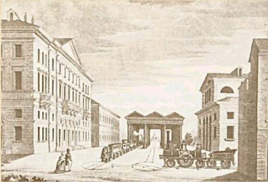
Stazione della Milano - Monza. Si notino le piattaforme girevoli con le quali si permetteva alle locomotive di invertire il senso di marcia www.storiadimilano.it/.../ferrovie/ferrovia.htm
